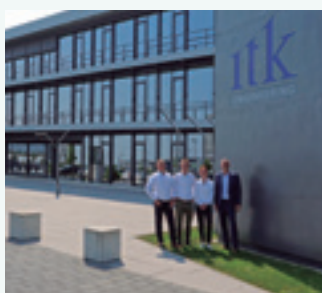
ITK Engineering GmbH. Inovativna poslovna zgrada u Nemačkoj. ECOi - PACi
